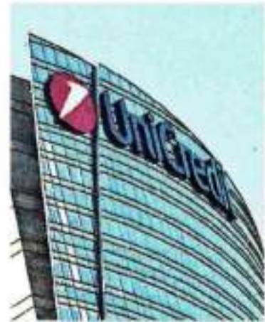
La torre Unicredit in piazza Gae Aulenti a Milano
