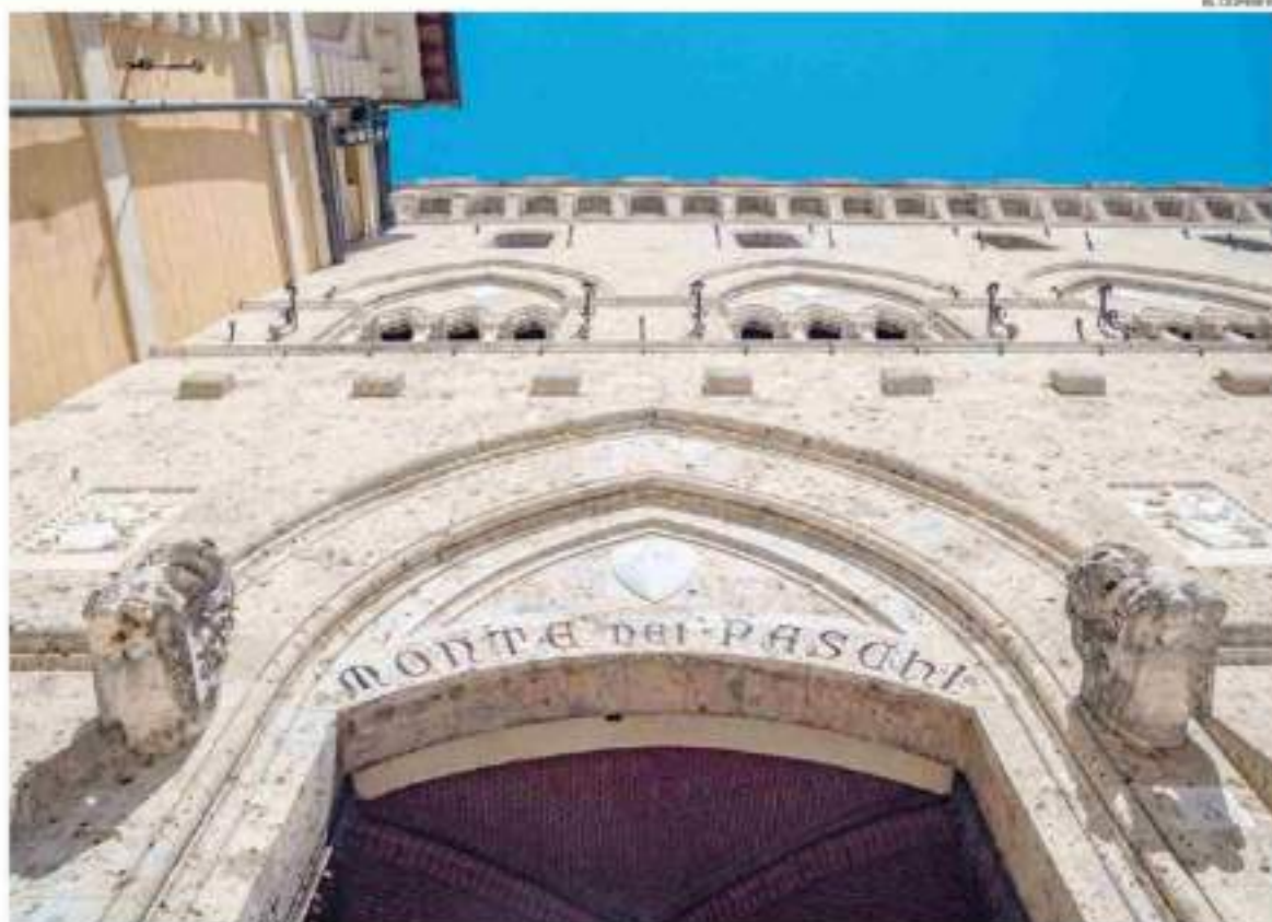
La sede. Il palazzo storico di Rocca Salimbeni nel centro di Siena sede della banca
