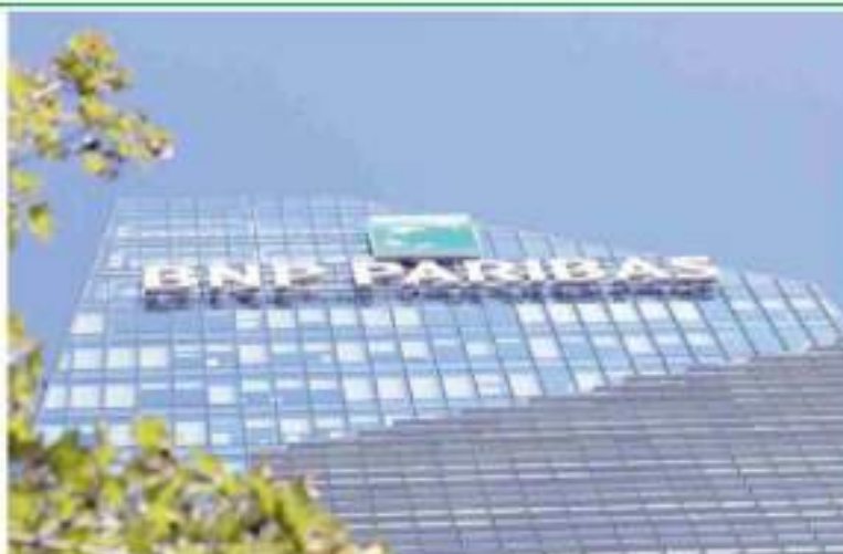
L'immobile. Veduta dal basso di Torre Diamante, a Milano
