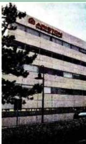
La sede di Ariston
